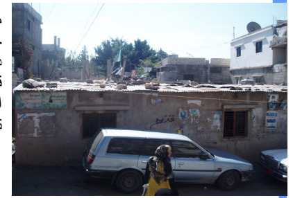
منزل حسن دحويش قبل إعادة تأهيله
